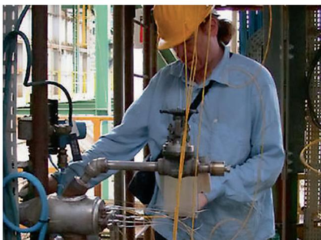
Осуществление монтажа диагностической камеры многозонной термопары (шеф-монтаж осуществляет сервисный специалист производственного центра Endress+Hauser Wetzlar, Германия)
