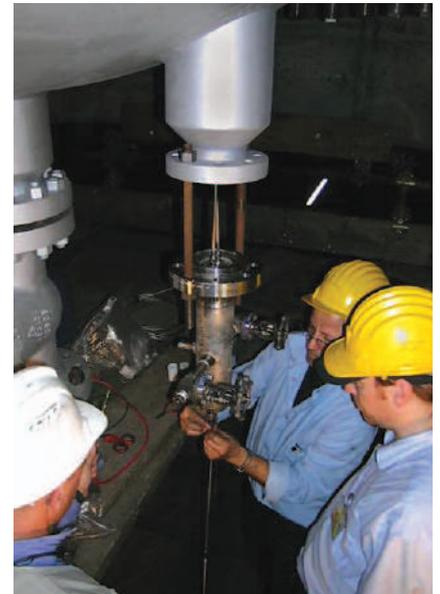
Монтаж многозонной термопары в реактор
